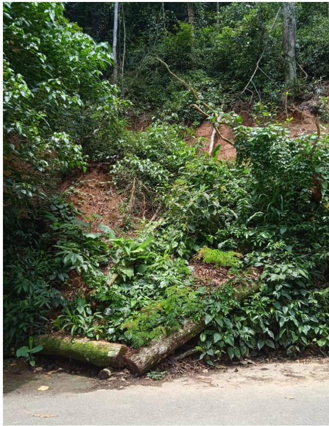
Figura 10: Movimento de massa gravitacional que mobilizou diversas árvores de médio à pequeno porte fotografia de (09/11/2022)
