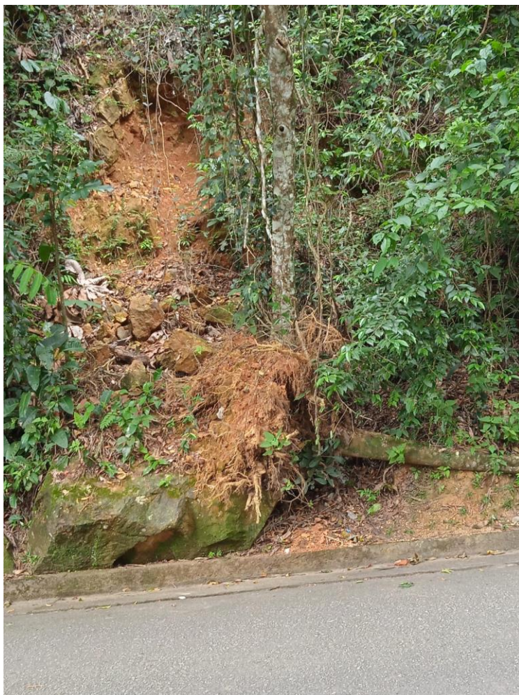
Figura 8: Queda de árvore enraizada no substrato rochoso alterado e fraturada (fotografia de 21/10/2022).
