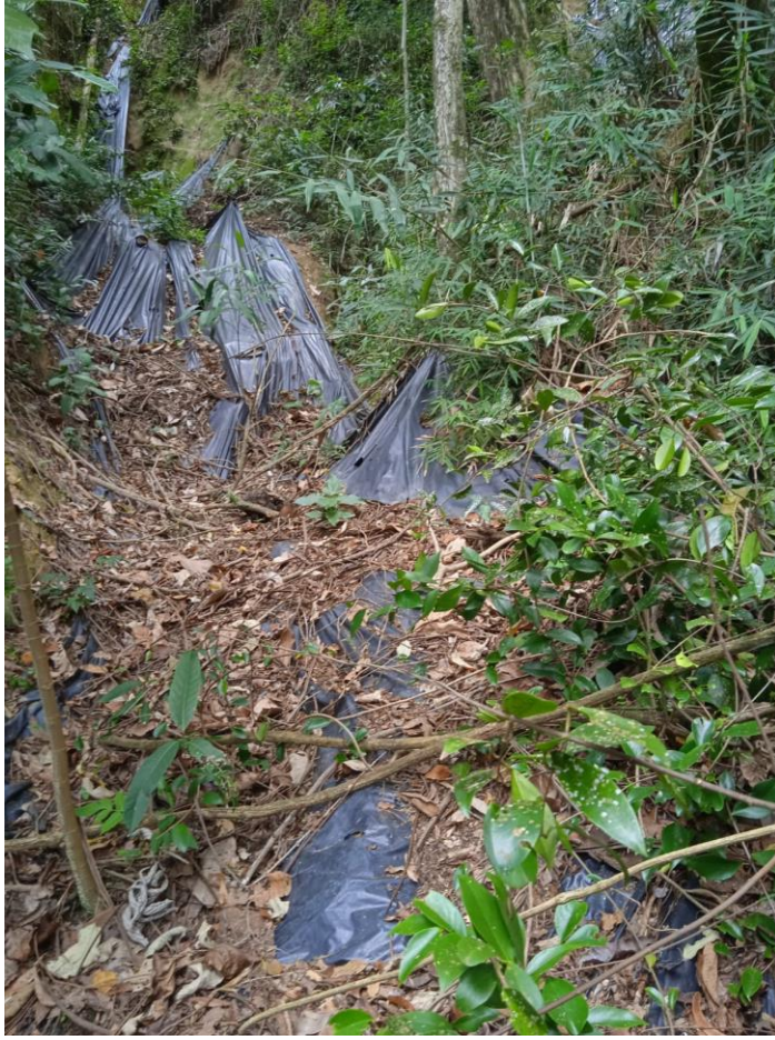
Figura 2: Movimento de massa ativo com impermeabilização emergencial com lona, que está rasgada em alguns pedaços (fotografia de 14/10/2022)
