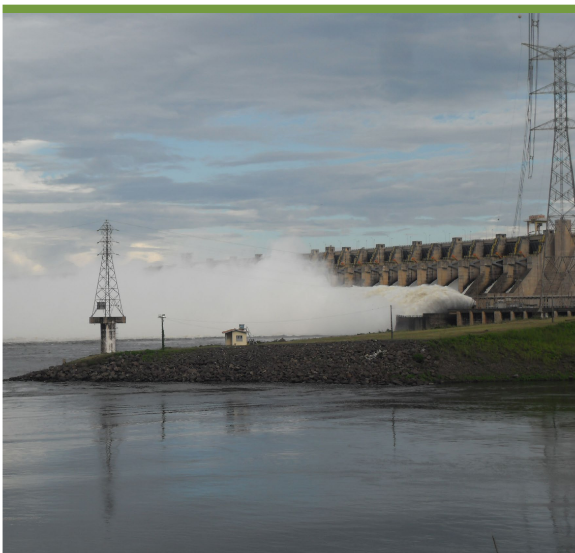
Usina Hidrelétrica de Tucuruí/PA. Foto: Diego Pereira
