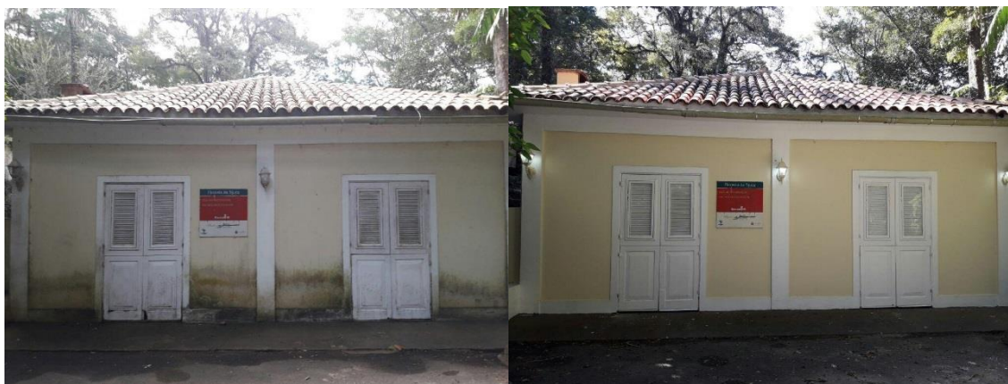
Figura 85 e 86 – Antes e depois da reforma da Casa do Pesquisador no setor Floresta.
