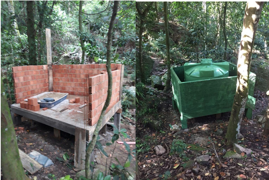
Figura 78 e 79 - construção da caixa d'água na guarita da Pedra da Gávea.
