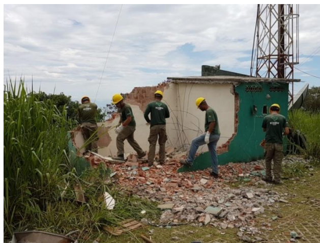
Figura 31: Demolição da benfeitoria da empresa FortNet.
