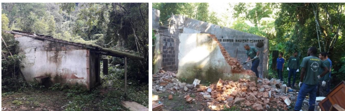
Figura 32 - Demolição da casa que era ocupada por Maria Lúcia Liduino Nascimento.
