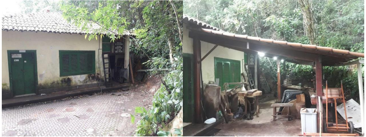
Figura 80 e 81 - construção do telhado para ampliar a área da oficina da Equipe de Monitoria de Trilha.
