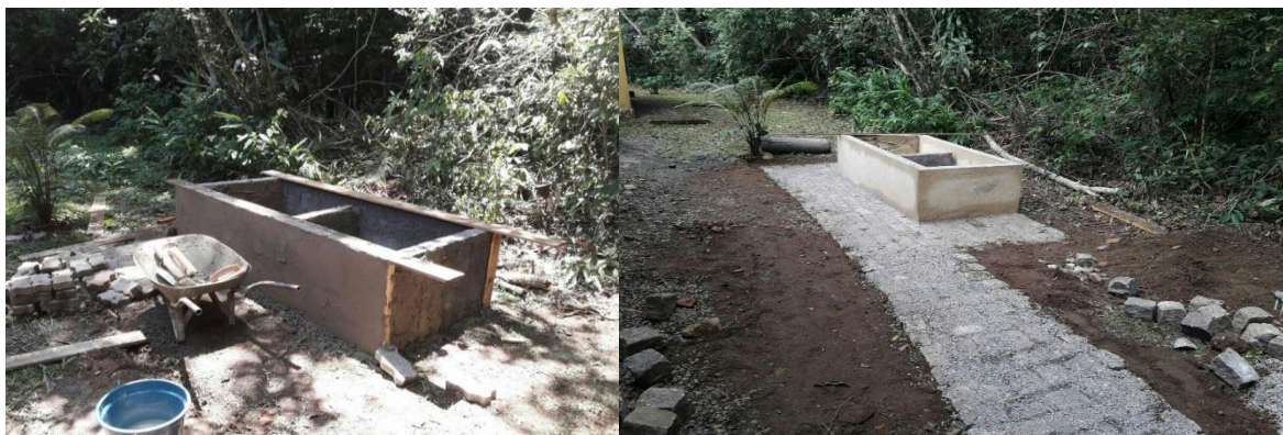
Figura 87 - Construção da composteira no Centro de Visitantes Setor Floresta.
