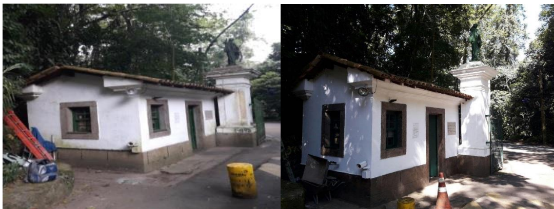
Figura 83 e 84- Guarita de saída do Setor Floresta totalmente reformada.
