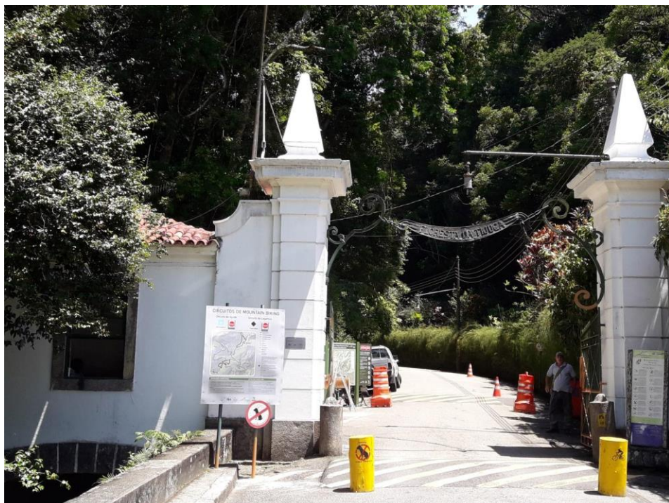
Figura 82 - guarita de entrada do setor Floresta totalmente reformada.
