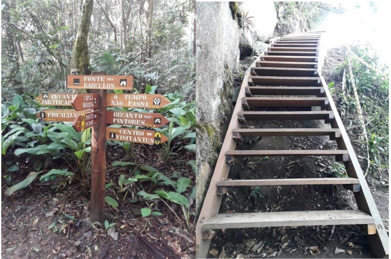
Figura 18: Sinalização rústica instalada em trilha e Figura 19: Construção de escada na Trilha do Bico do Papagaio
