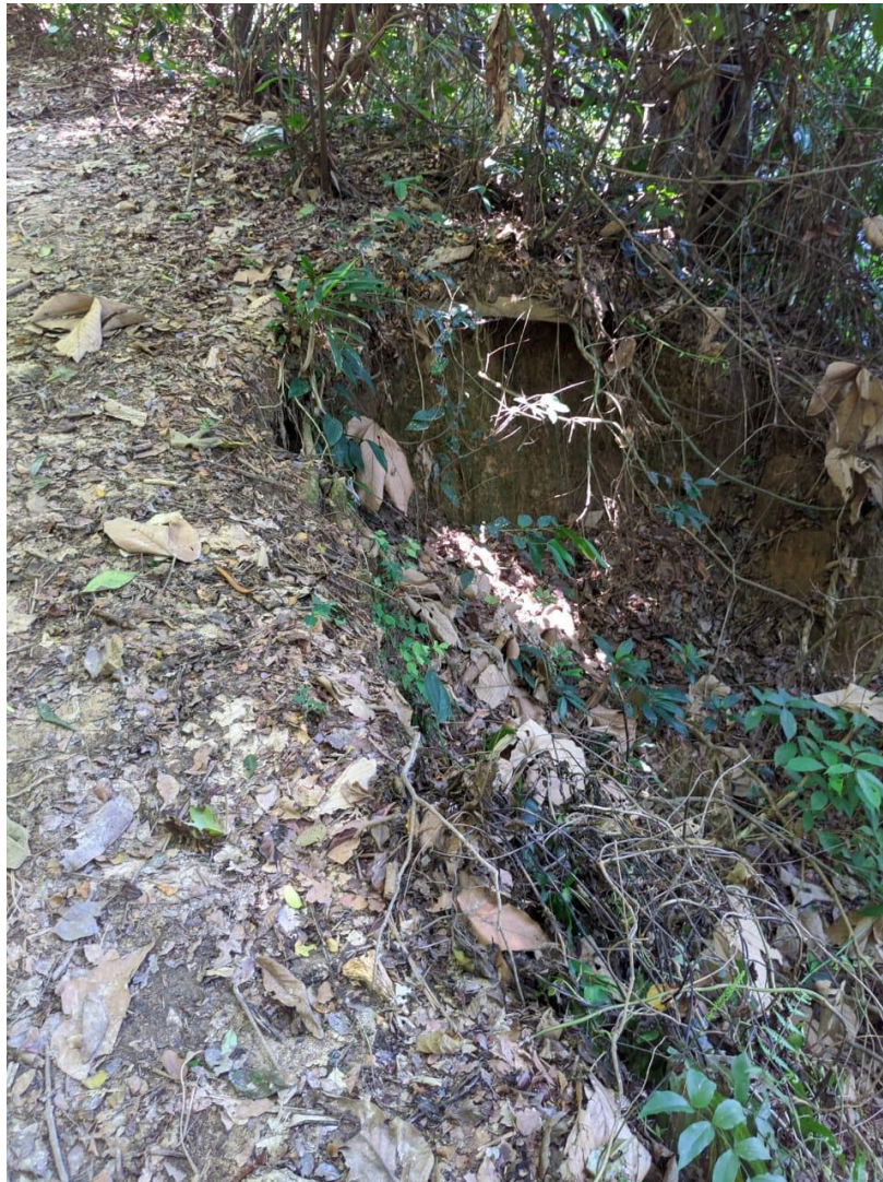
Figura 4.1.2 - Erosão na beirada da trilha, no Ponto TPLC04 provocado pelo escoamento superficial de água e fluxo de pessoas.
