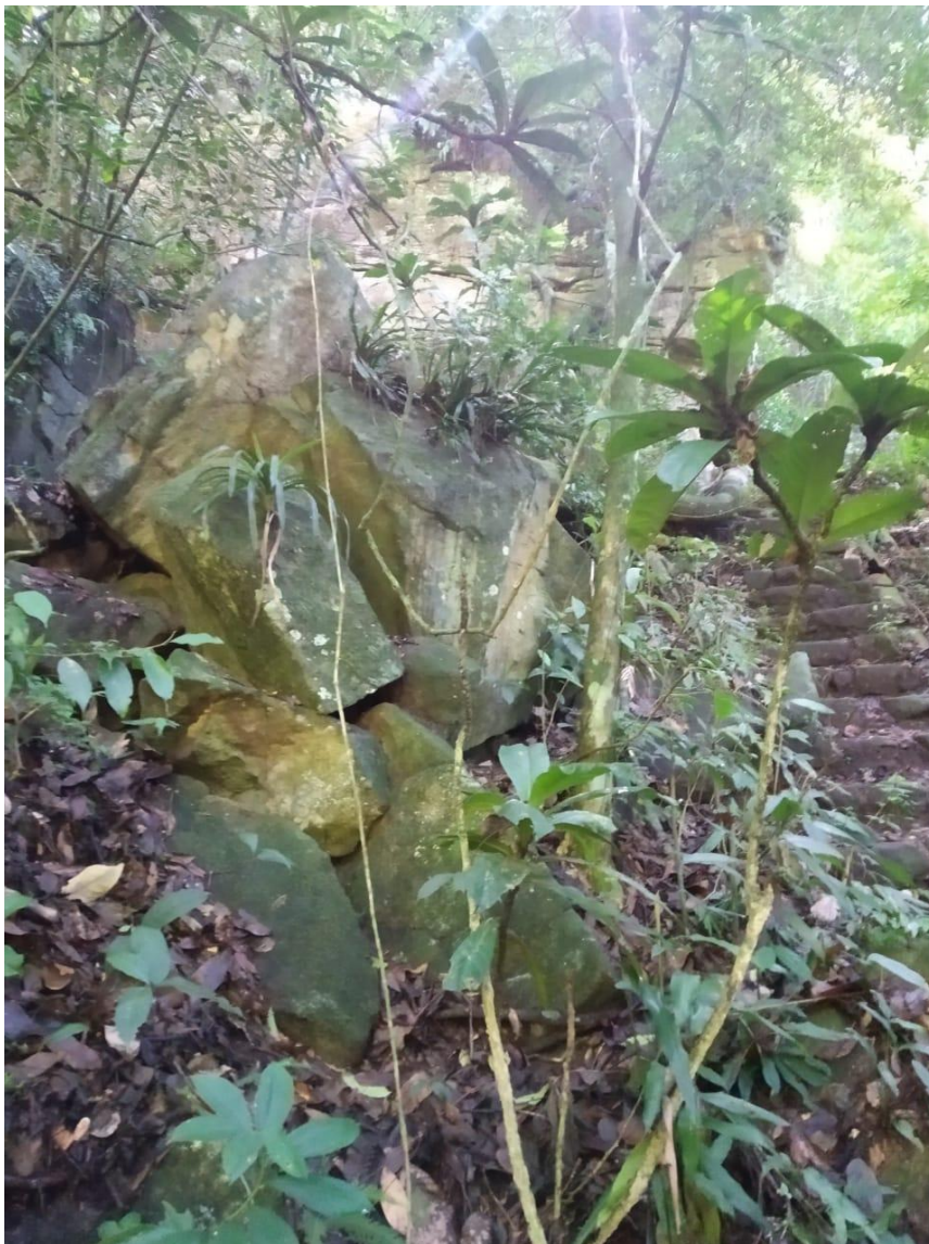
Figura 4.6.5: Imagem dos blocos soltos na encosta mais abaixo do ponto TRC-010.
