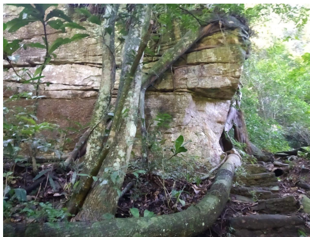
Figura 4.6.3: Imagem de paredão fraturado muito próximo a trilha.
