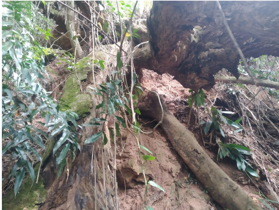
Figura 4.5.2: Deslizamento ocorrido no ponto TMI-015
