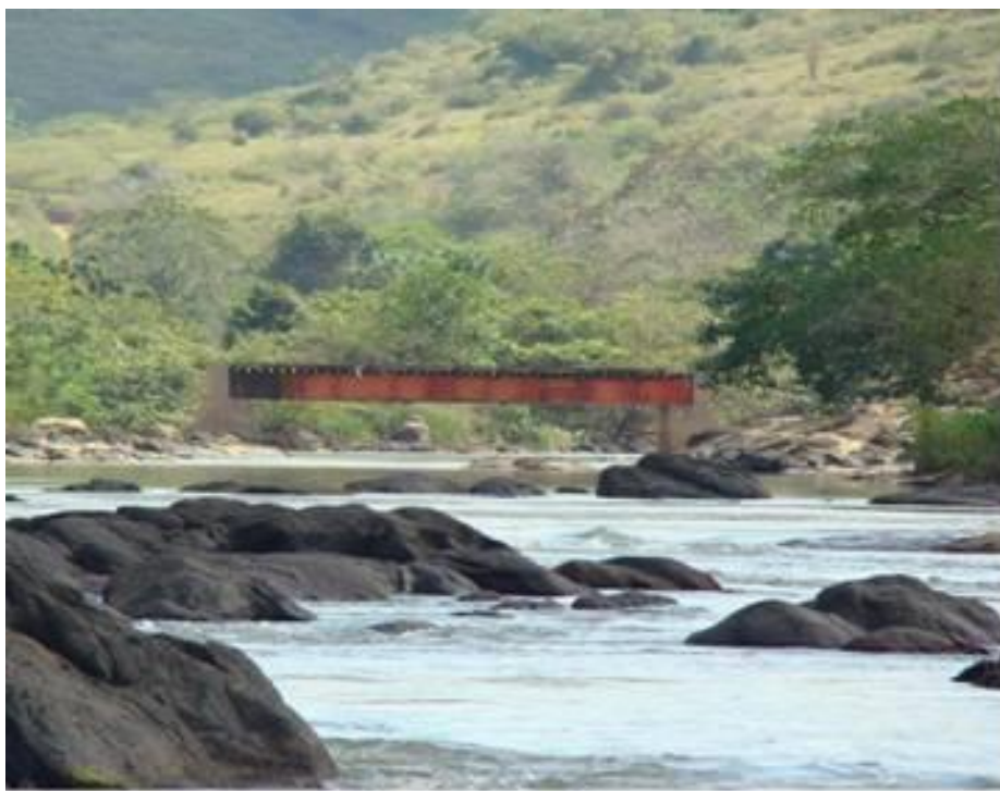
Fig. 6 – Base da usina que apresenta seu projeto embargado nas margens do Rio Mucuri, município de Carlos Chagas/MG.
