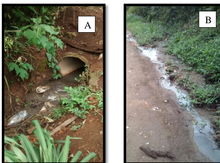
Figura 7 - Esgoto a céu aberto na Est. Jorge Kutova (A e B)
